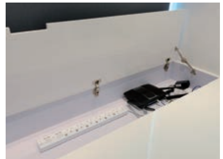
書檯檯面造設向上打開的櫃門，櫃內藏了插頭、拖板和電線等。
